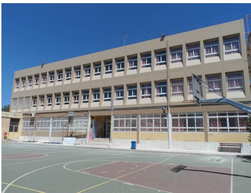
ΑΠΟΛΟΓΙΣΜΟΣ ΕΡΓΑΣΙΩΝ ΣΥΝΤΗΡΗΣΗ ΣΧΟΛΙΚΩΝ ΚΤΗΡΙΩΝ ΠΕΡΙΟΔΟΥ 2015 – 2016
